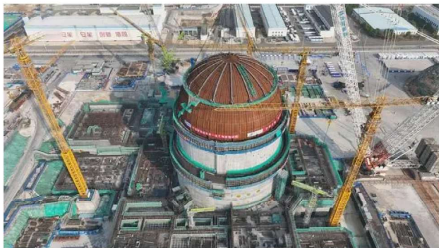
图 6-6 正在吊装穹顶的华能海南昌江核电二期工程 3 号机组
